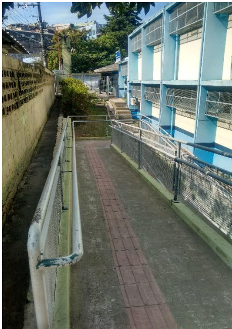
RAMPA DE ACESSO AO PAV INFERIOR
