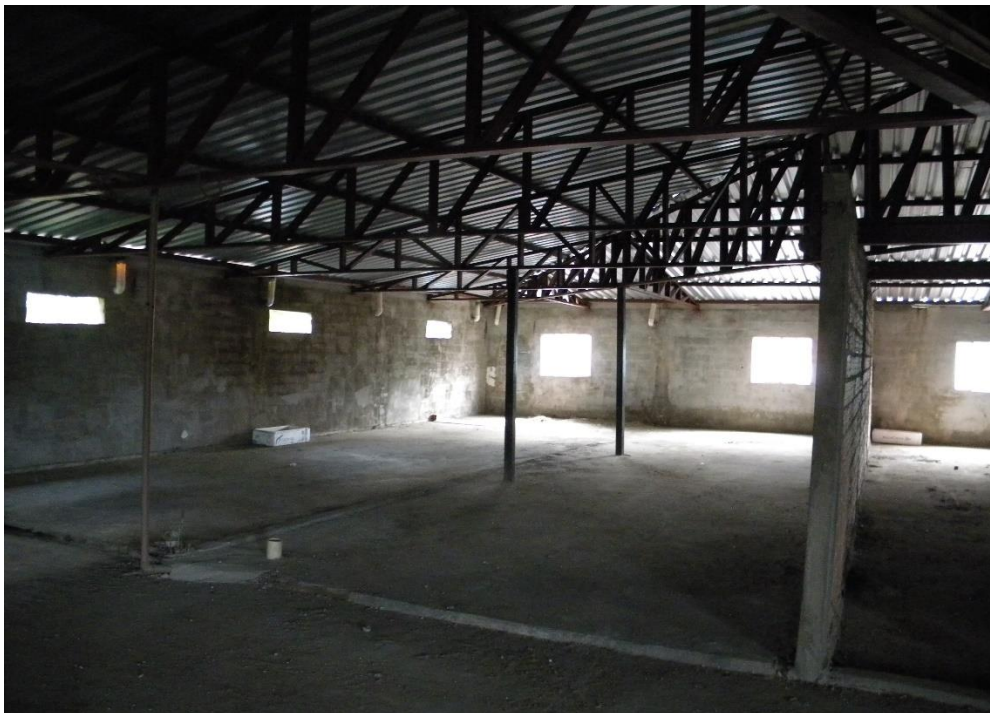
VISTA DA ALVENARIAS INTERNAS EXISTENTES DE TIJOLO CERAMICO
