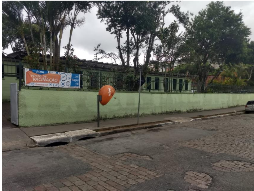
3. Fachada da Unidade
