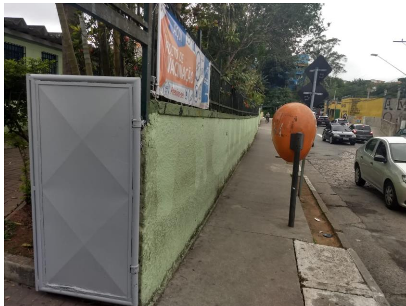
4. Fachada da Unidade
