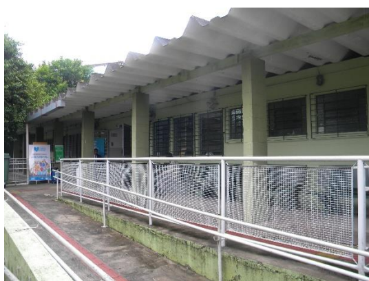
RAMPA DE ACESSO
